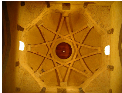
coupole – Hôpital Saint Blaise
